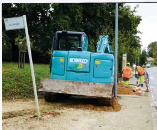
Début des travaux pour l'arrivée de la fibre optique et du haut débit au Verger
