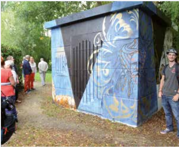
Street art : le transformateur relooké par une création visuelle contemporaine
