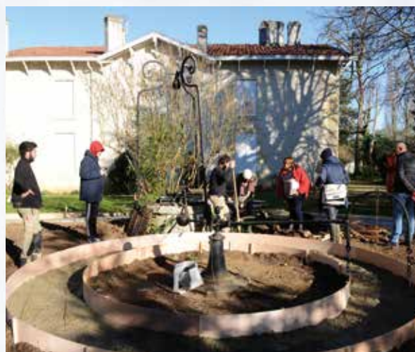
Réunion de chantier autour de la noria du Parc Marès.
